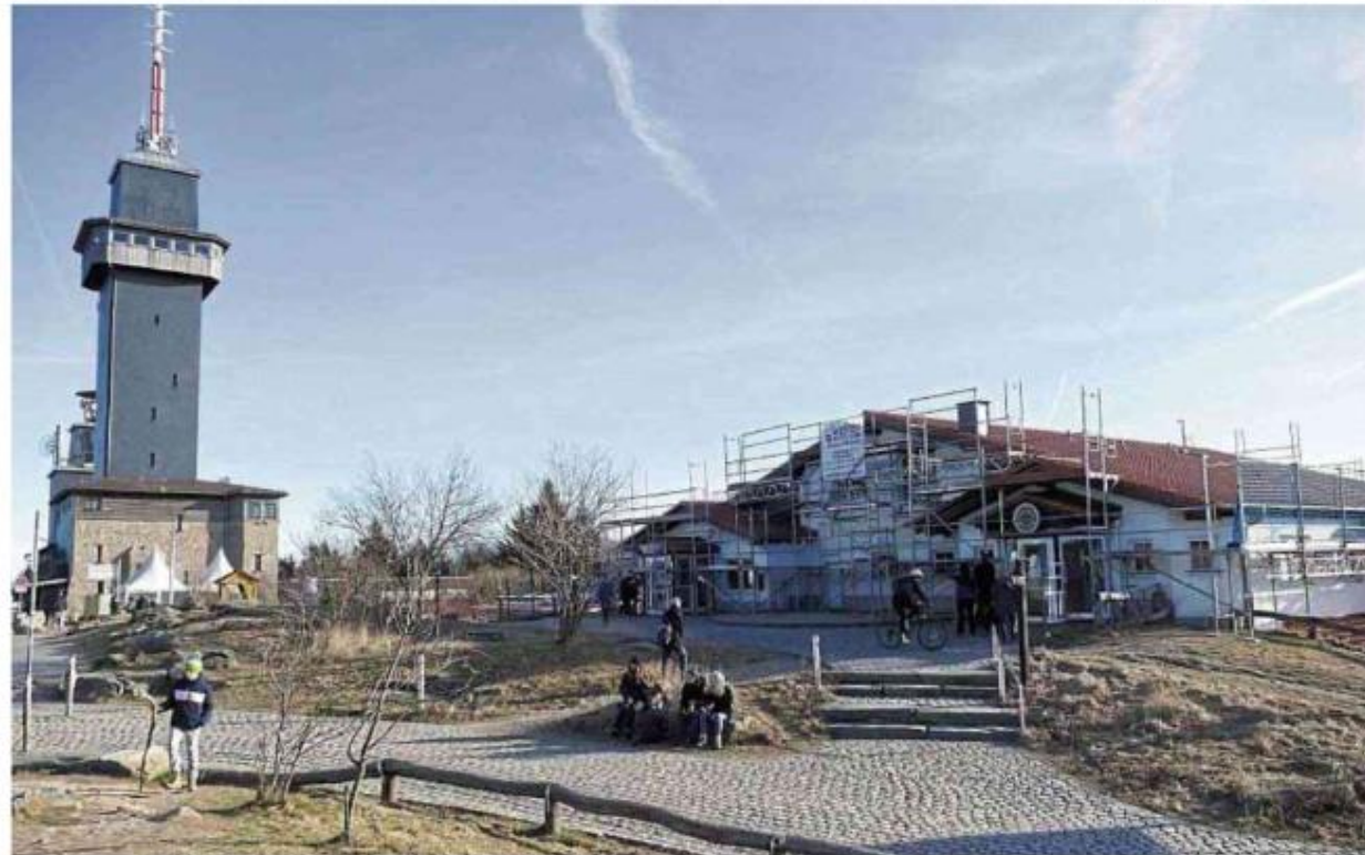
Das Gerüst am Feldberghof auf dem Feldberggipfel steht bereits.
